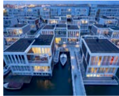
Waterwoningen IJburg, Amsterdam Marlies Rohmer
