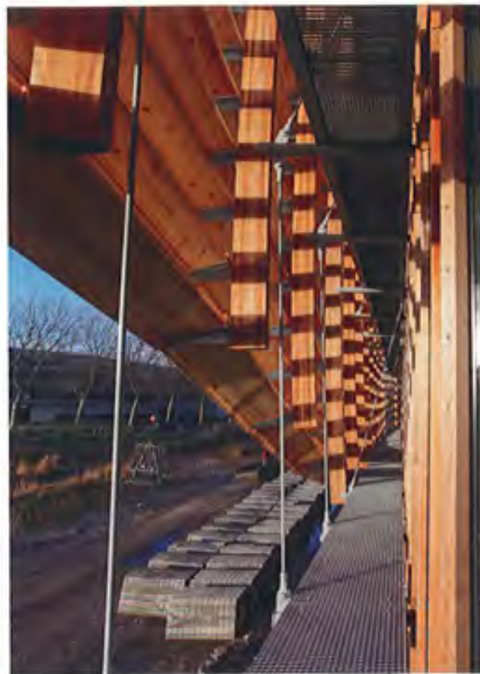
Tussen de lamellen en de glasgevel hangen glazenwatersbàkjes met roostervloeren aan Willemz-ankers.
