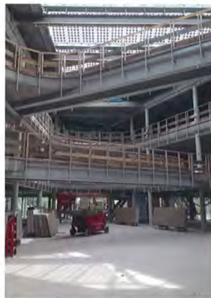
Staalconstructie van de bruggen in het atrium.
