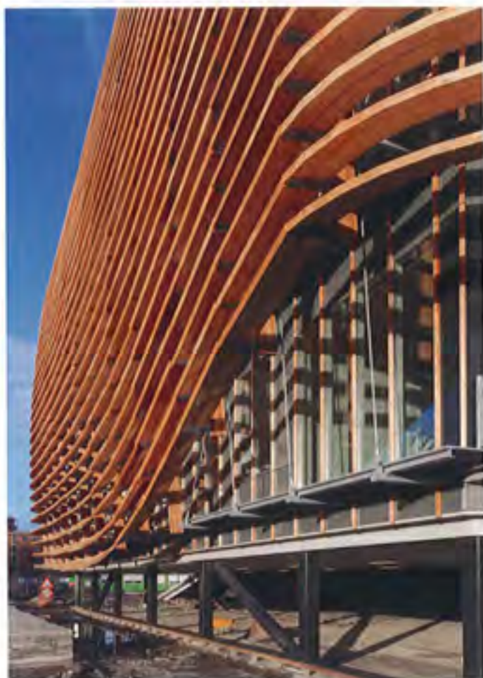
Nabij de hoofdentree worden de golven met lamellen als het ware omhoog geduwd.
