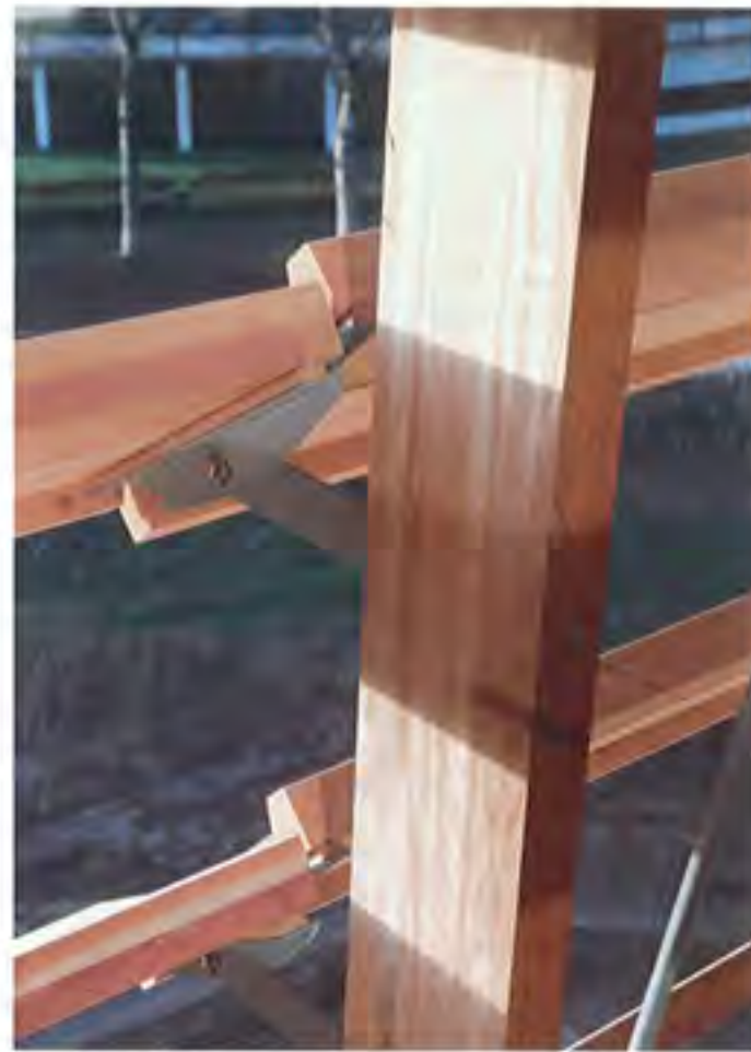
De consoles zijn in drie richtingen te stellen: om de as, door de verstelbare hoekprofielen en op de halfronde lat op de profielen.
