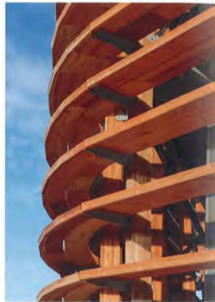
Voor de afgeronde gebouwhoeken zijn speciale, gesegmenteerde hoekstukken gemaakt.
